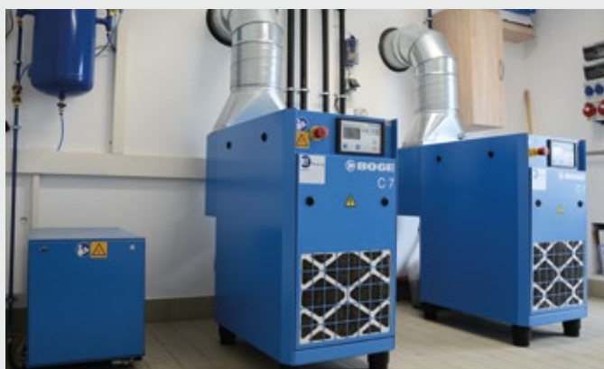
Przykładowy system odprowadzania powietrza z kompresora
